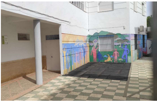
Imagen del Centro antes de las obras.
